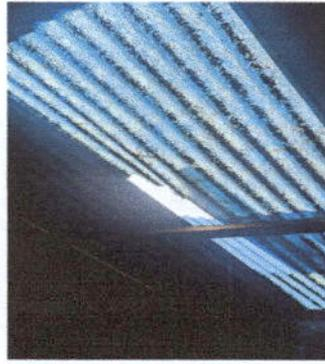
Foto1: Sustitución de lámina, por lámina troquelada calibre 26 y soporte de madera por metal.
